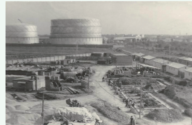
建所初期施工场景
